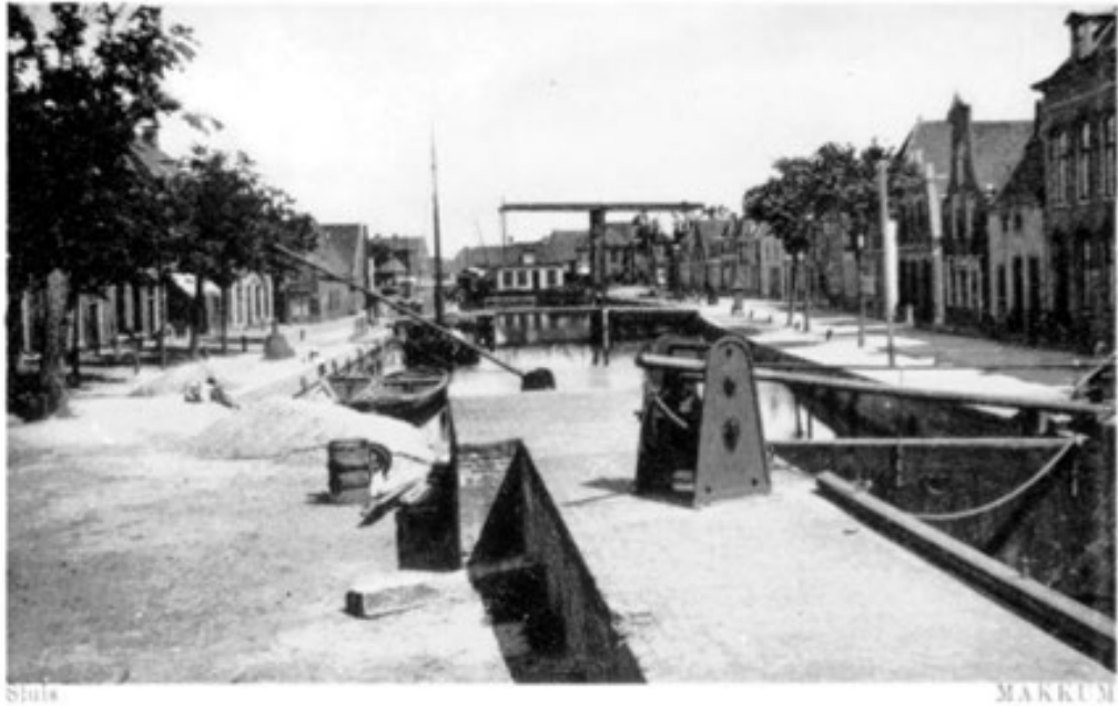
Figuur 6 Sluis in Makkum
